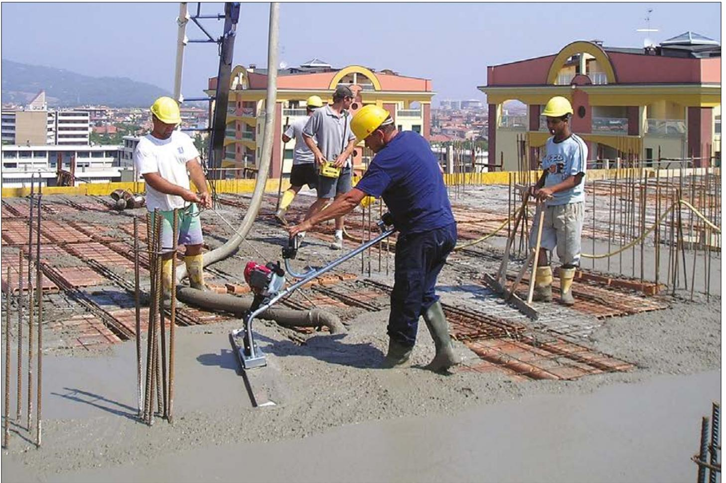
**2.** Il motore 4 tempi Honda HP 1.1 con accensione e regolazione controllata permette di mantenere costante il regime di giri.
